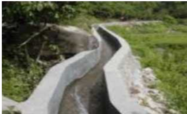
Gambar 35. Headrace Sumber : adesalinfo
