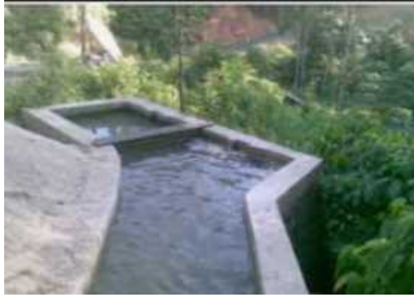
Gambar 34. Bak pengendap Sumber : upj.ac.id
