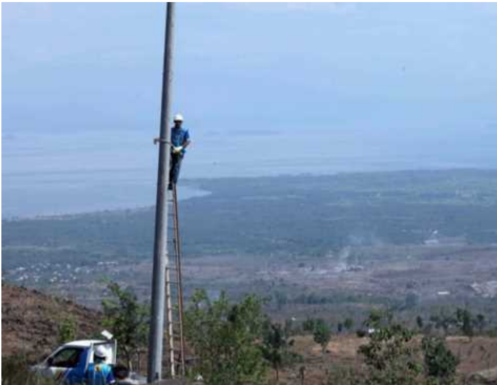
Gambar 43. Pembangunan Tiang Listrik Sumber : Detik.com
